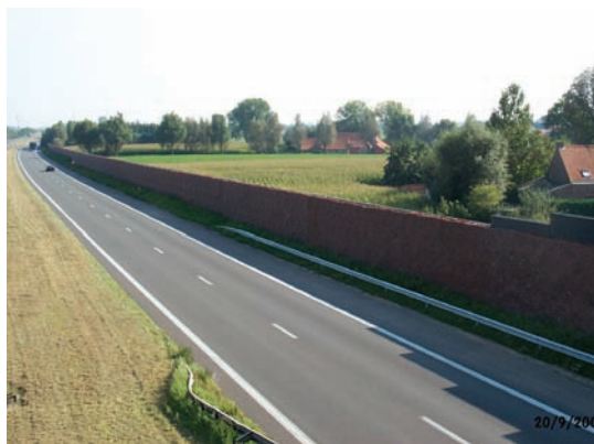
realisatie ontwerp G. Derveaux, het scherm werd opgebouwd uit schanskorven gevuld met terracottascherpen, als verwijzing naar typisch materiaal uit de streek
